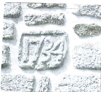
Cliché F1 : Date en façade à Kereven.
