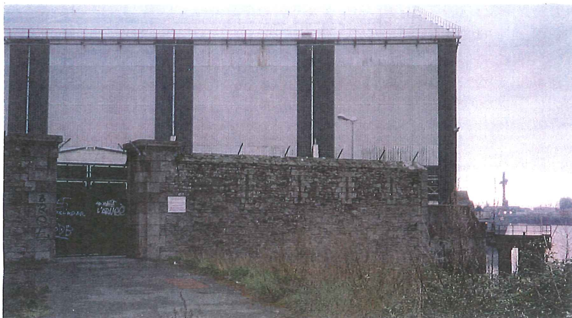
Le même mur avec ses meurtrières , vu vers le sud.
